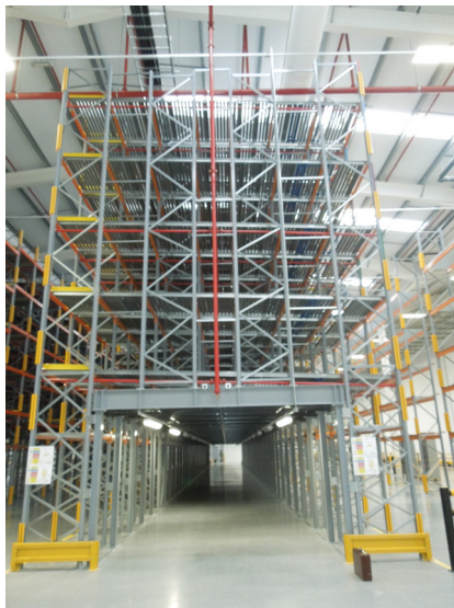
Instalación de pallet live con túnel de recogida
